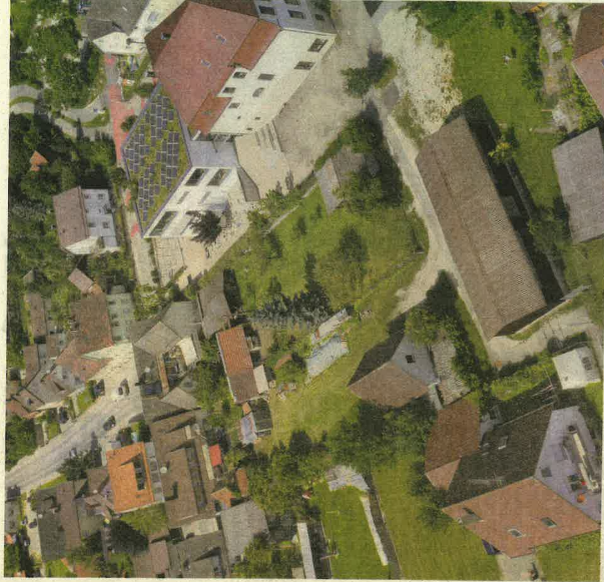
In der Oberlenninger Ortsmitte entsteht ein zweistöckiges Kinderhaus. An der Amtgasse (im Bild oben) wird das Gebäude für die Schulkindbetreuung gebaut, auf der gegenüberliegenden Seite der Freifläche unterhalb des Grundschulgebäudes das Haus für Krippen- und Kindergartenkinder. Foto: Jean-Luc Jacques
